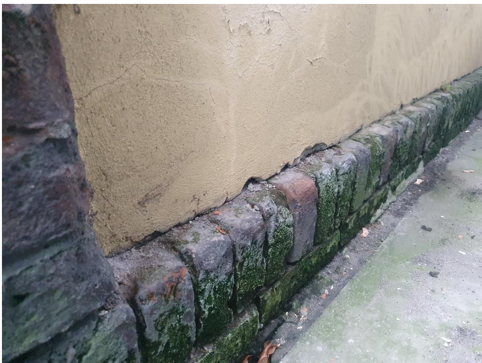
Fot. 5. Zawilgocenia, ubytki cegieł i fug, porost mchem i glonami
