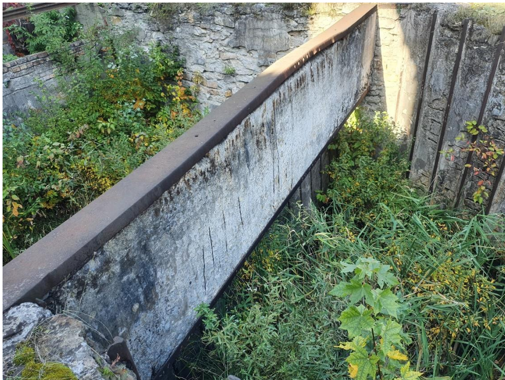
Fot. 3. Widok na drugą komorę od strony wschodniej – odspojenie i rozwarstwienia muru i okładzin zewnętrznych, zamulenie i porost roślinności
