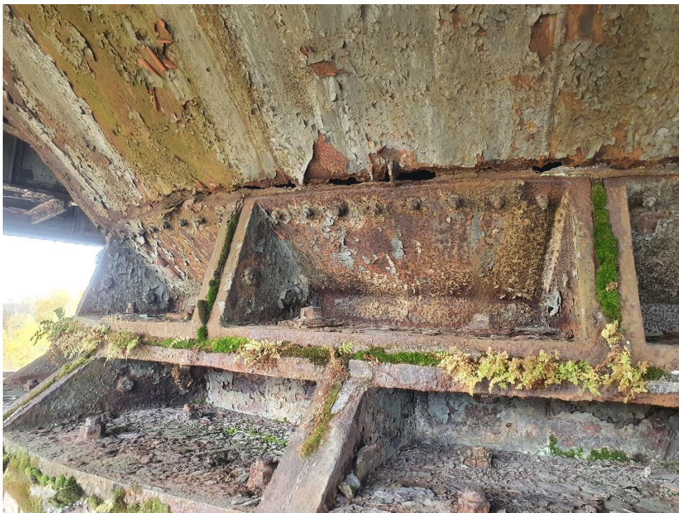
Fot. 9. Korozja blach leja Wielkiego Pieca
