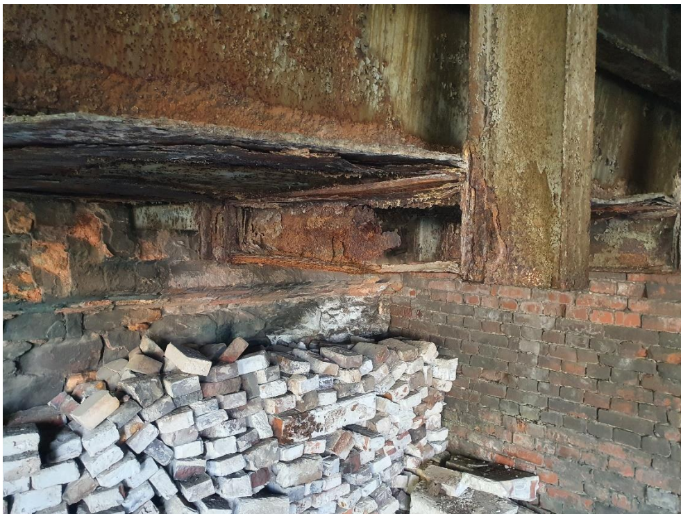
Fot. 11. Korozja belek podpierających pomost na poziomie \pm 0,00
