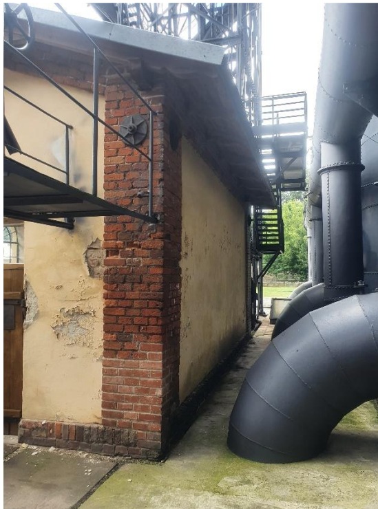
Fot. 2. Widok od strony południowo-wschodniej - zawilgocenia, ubytki cegieł i fug, odspojenie i rozwarstwienie tynków
