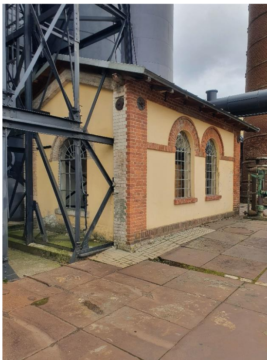
Fot. 1. Widok od strony północno-zachodniej - zawilgocenie przyziemia, odspojenie i rozwarstwienie tynków
