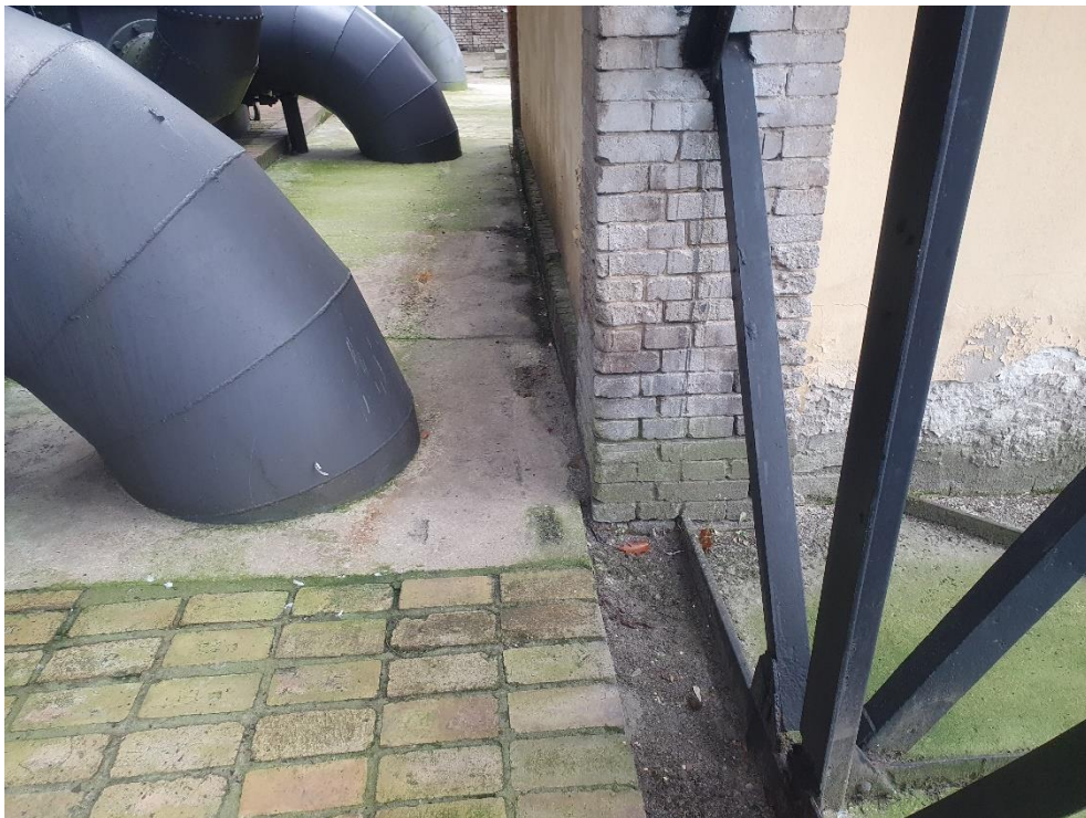
Fot. 3. Widok od strony północno-wschodniej - zawilgocenie przyziemia, odspojenie i rozwarstwienie tynków
