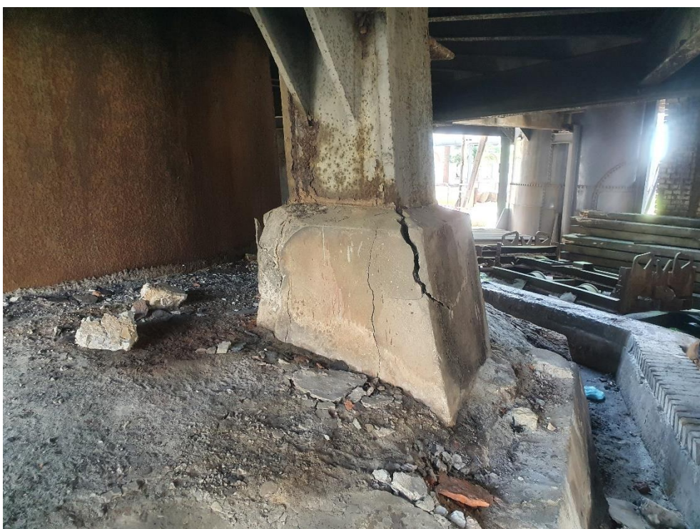
Fot. 4. Spękany fundament słupa wsporczego
