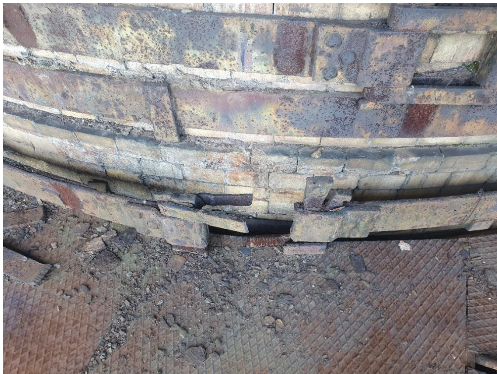
Fot. 7. Skorodowane i popękane klamry ściągow
