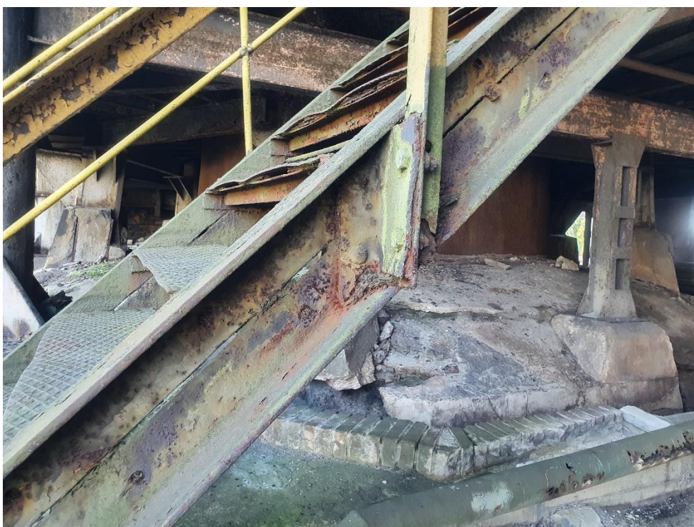
Fot. 14. Stan konstrukcji schodów prowadzących na pomost \pm 0,00
