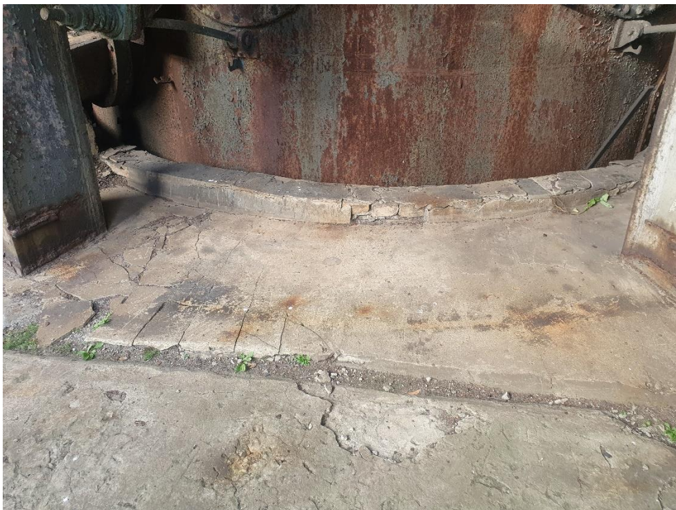
Fot. 13. Odspojenia płyty betonowej pomostu na poziomie \pm 0,00
