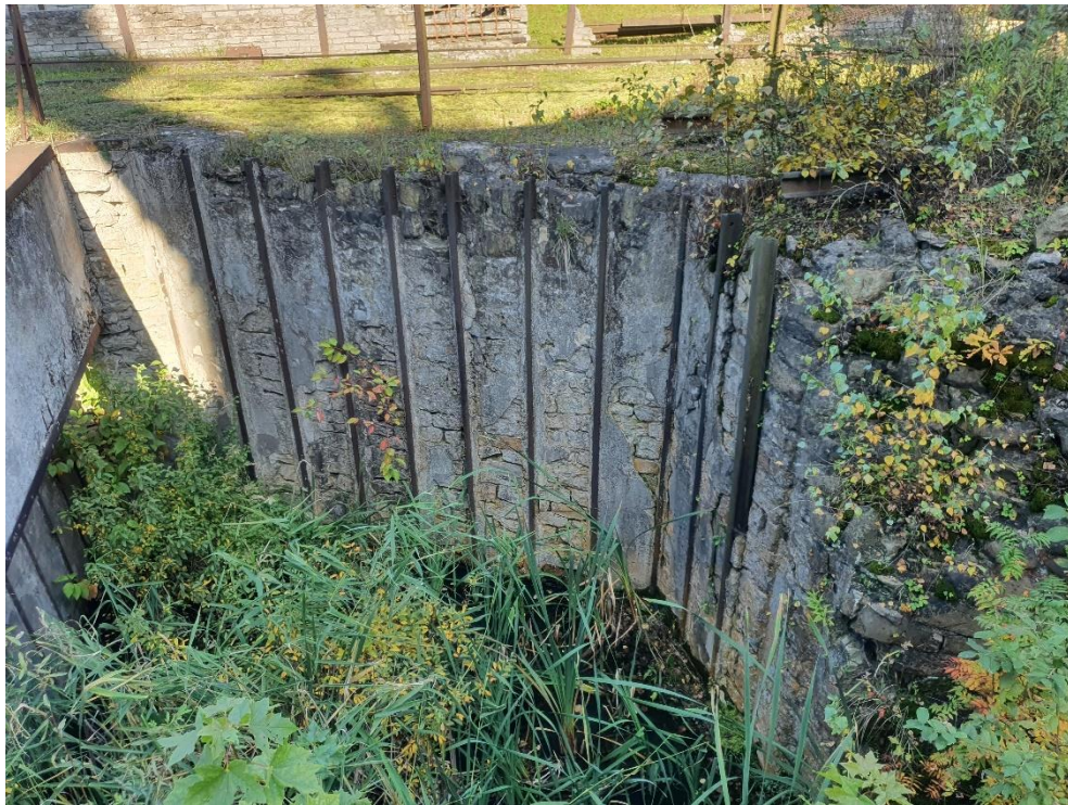
Fot. 2. Widok na pierwszą komorę od strony wschodniej – odspojenie i rozwarstwienia muru i okładzin zewnętrznych, zamulenie i porost roślinności
