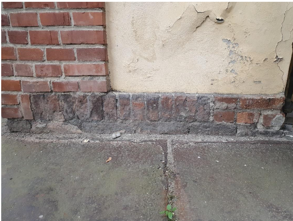
Fot. 4. Zawilgocenia, ubytki cegieł i fug, odspojenie i rozwarstwienie tynków
