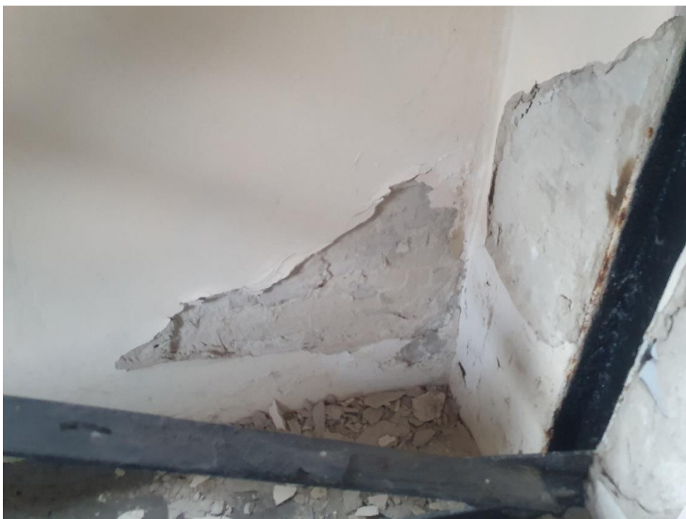
Fot. 7. Odspojenie i rozwarstwienie tynków
