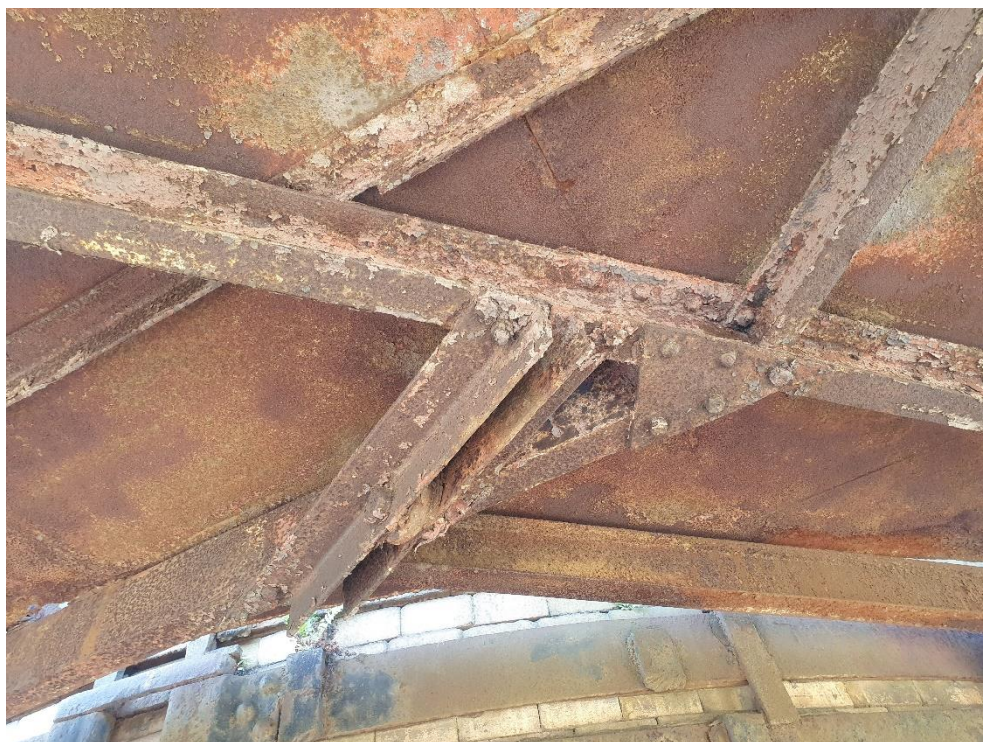
Fot. 17. Stan konstrukcji nośnej pomostu
