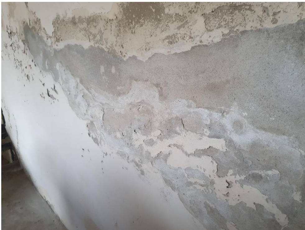
Fot. 6. Zawilgocona ściana, odspojenie i rozwarstwienie tynków, wysolenia
