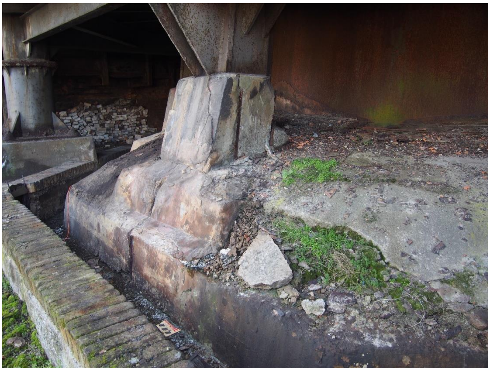
Fot. 3. Spękany fundament słupa wsporczego
