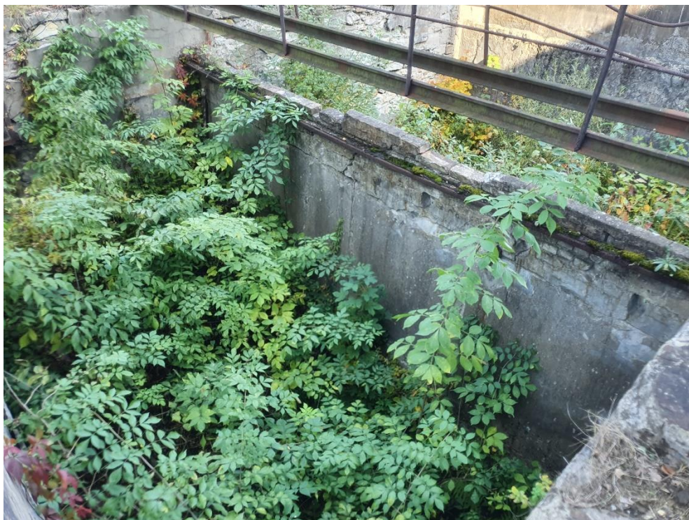
Fot. 4. Widok na ostatnią komorę od strony wschodniej – odspojenie i rozwarstwienia muru i okładzin zewnętrznych, zamulenie i porost roślinności
