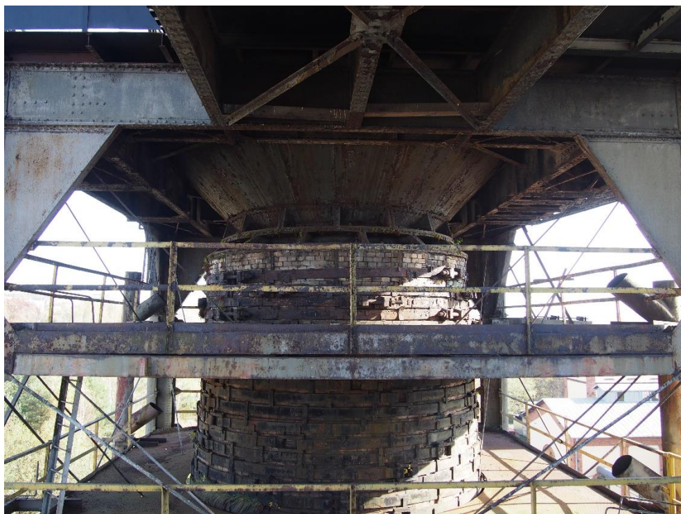
Fot. 6. Spękane i skorodowane opaski okalające Wielki Piec, ubytki w spoinach konstrukcji murowej
