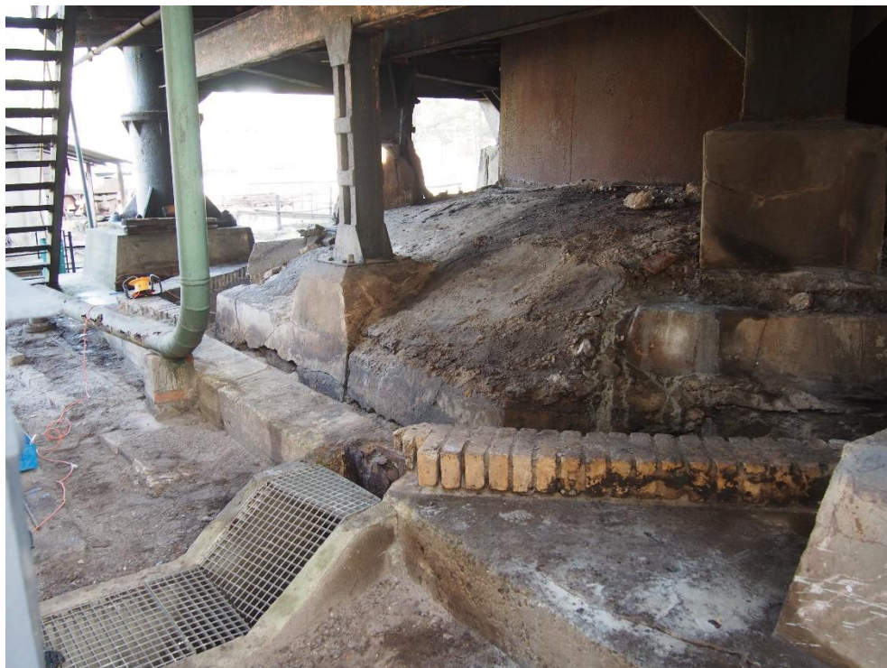
Fot. 5. Cokoły okalające kanał całkowicie pozbawione wymurowanych szczytów
