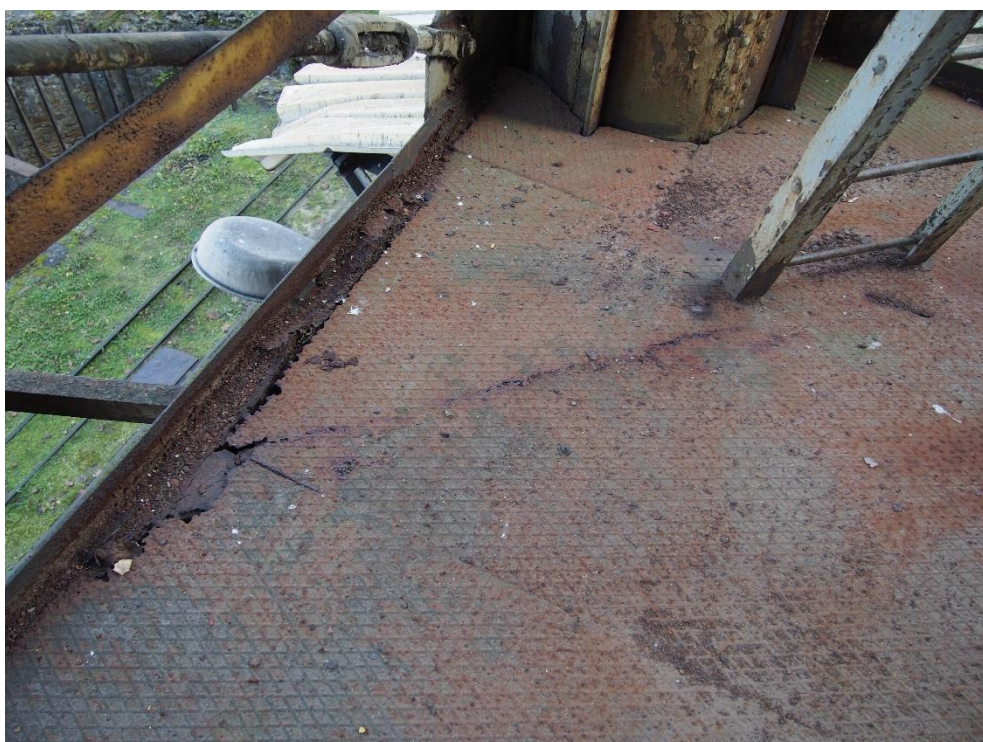
Fot. 18. Stan blach pomostu i drabin prowadzących na wyższe poziomy
