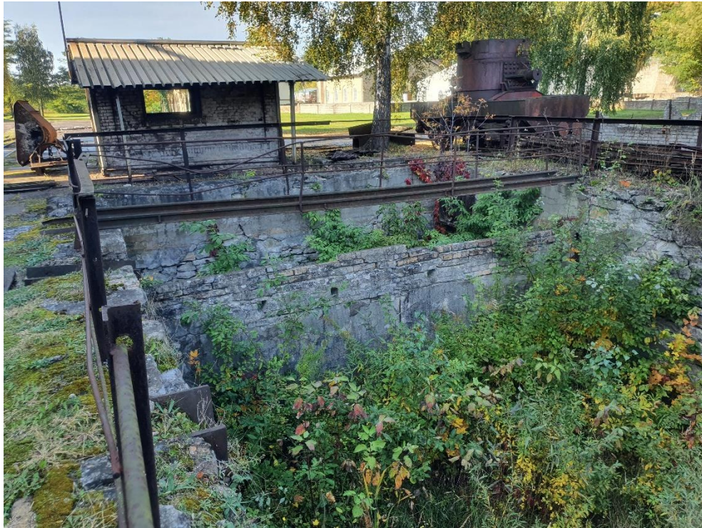
Fot. 1. Widok na Zbiornik – odspojenie i rozwarstwienia muru i okładzin zewnętrznych, zamulenie i porost roślinności
